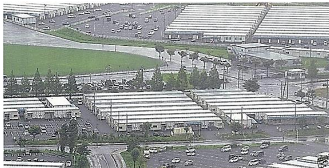
宮城県石巻市の開成地区と南境地区にあるプレハブ仮設住宅＝福留唐女撮影
